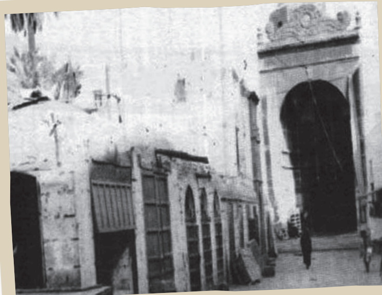
کوچه بنی هاشم که در حال حاضر تخریب شده است
